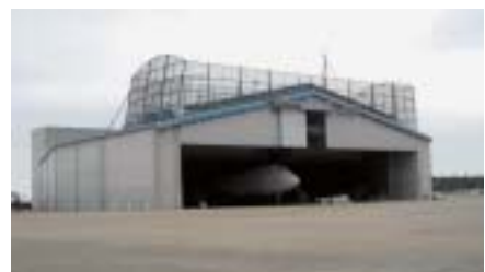
成田空港の格納庫タイプの南風用消音施設(ノイズリダクションハンガー)
