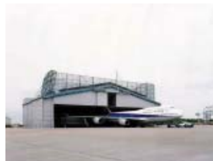
成田空港の格納庫タイプの南風用消音施設 (ノイズリダクションハンガー)
