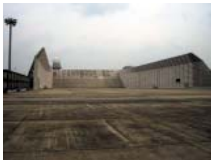
伊丹空港の大型防音壁を備えたエンジン試運転場
