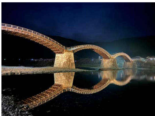
(山口県岩国市 錦帯橋)
