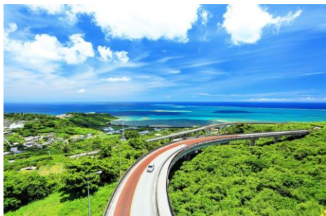
ニライ橋 カナイ橋
