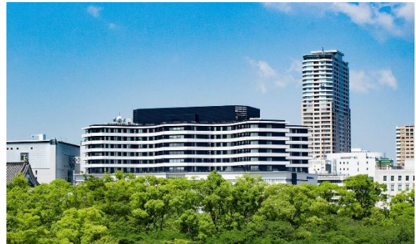
大阪国際がんセンター（外観）
