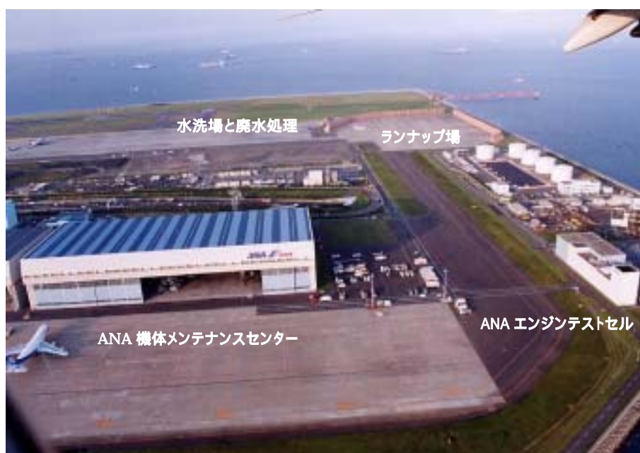
羽田空港 ANA 機体メンテナンスセンター、エンジンテストセル と ランナップ場、水洗場
